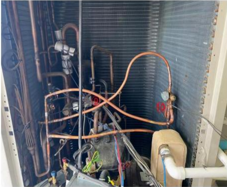
Şekil 10. Plakalı Isı Değiştirgeci Bakır Boru Bağlantısı Görseli
